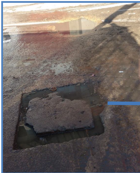
Figura 10.- Entre las Mz 4 y Mz 2. Se observa sobre la calzada la presencia de líquido marrón sin escurrimiento. Los vecinos informan que la cámara recientemente ejecutada desborda continuamente.
