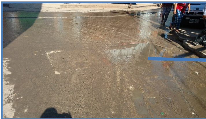
Figura 8.- Ana María Janer y Mz 6. Se observa sobre la calzada la presencia de líquido marrón sin escurrimiento. De acuerdo a lo manifestado por los vecinos, la cámara localizada sobre Ana María Janer, desborda continuamente y es permanente la presencia de líquido sin escurrimiento en la calzada. El Vector concurre cada 15 días a destapar la cámara.
